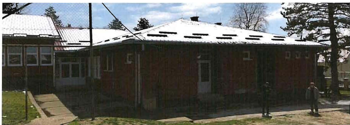
Фотографије фасада објекта бр. 2 – нова школа
