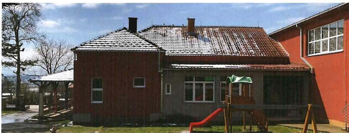
Фотографије фасада објекта бр. 1 – стара школа
