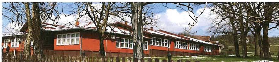
Фотографије фасада објекта бр. 2 – нова школа
