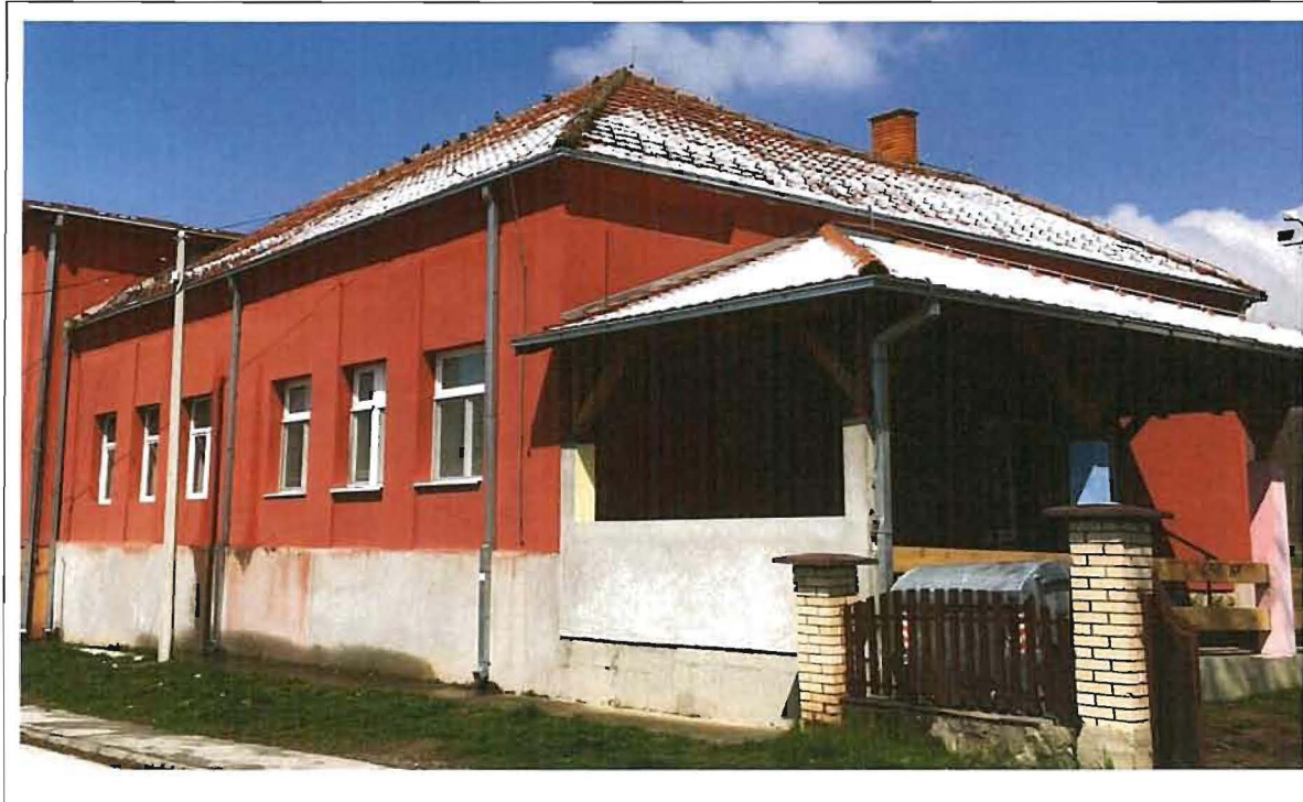
Фотографије фасада објекта бр. 1 – стара школа
